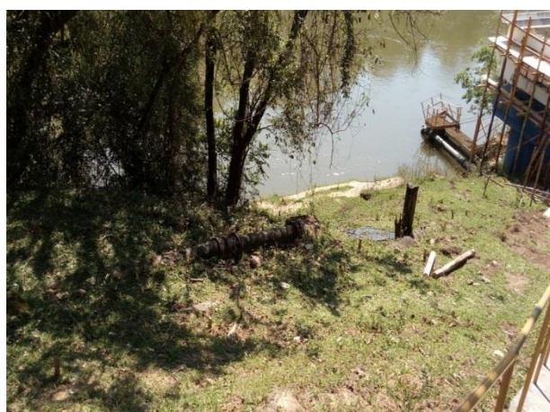
Figura 52: Primeiro trecho da adutora de água bruta.
