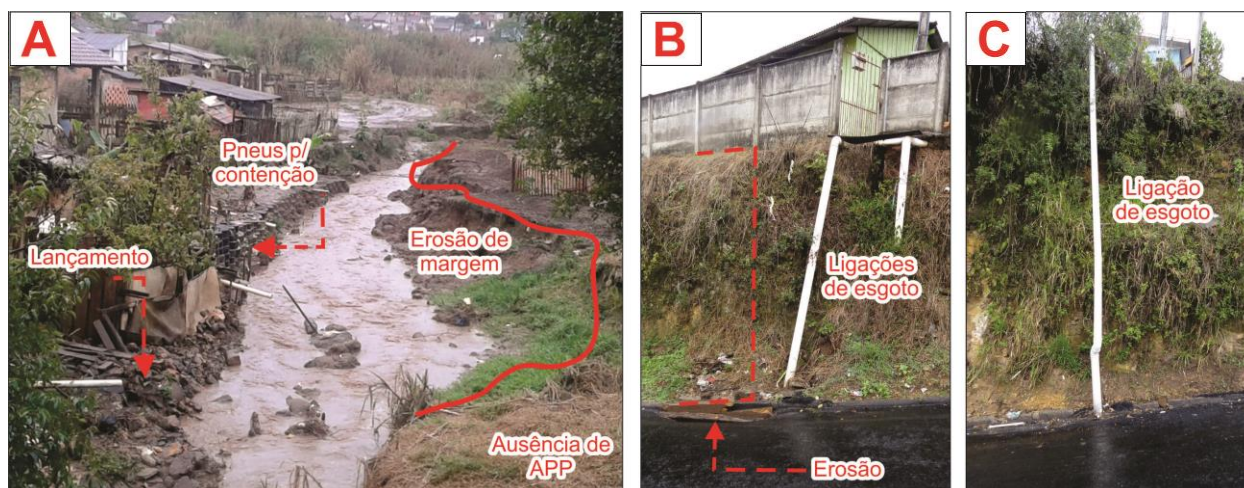
Figura 27: Uso e ocupação da terra inadequados e estruturas improvisadas de saneamento nos bairros Jardim Alegre (A) e Vila Esperança (B e C).
