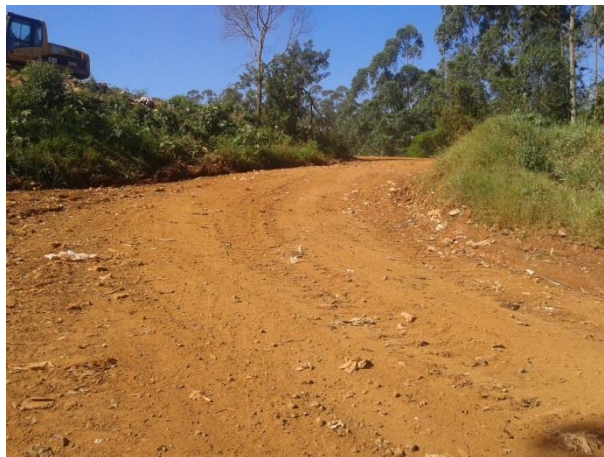
Figura 143: Estrada de acesso interno ao aterro sanitário.
