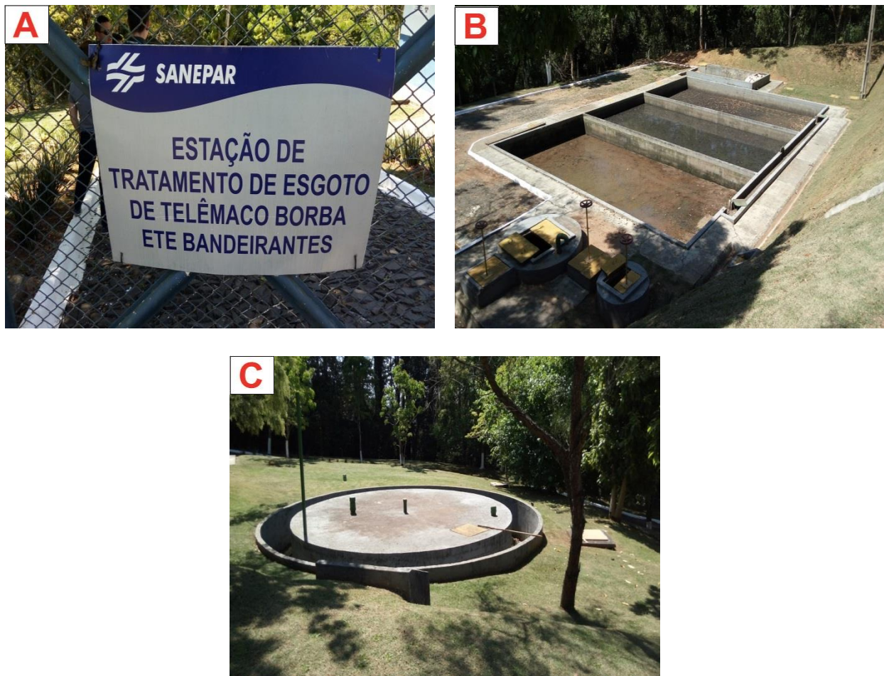
Figura 83: ETE Bandeirantes, detalhe da sinalização (A); leitos de secagem (B); RALF (C).
