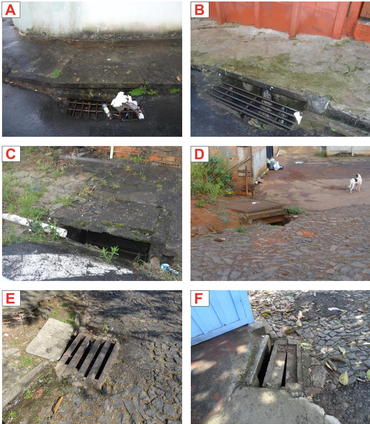
Figura 92: Tipos de boca de lobo encontradas em Telêmaco Borba - Boca de lobo com grades metálicas (A) e (B); boca de lobo sem nenhum tipo de contenção (C) e (D); boca de lobo com barras de ferro (E); boca de lobo em concreto (F).
