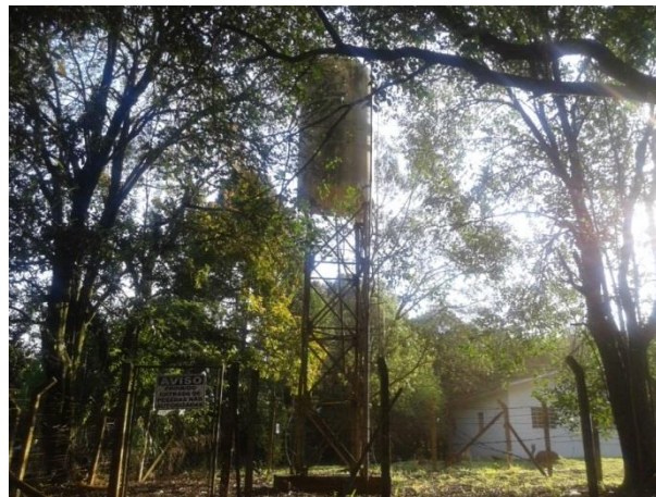
Figura 60: Reservatório Elevado (REL-03) – Triângulo.
